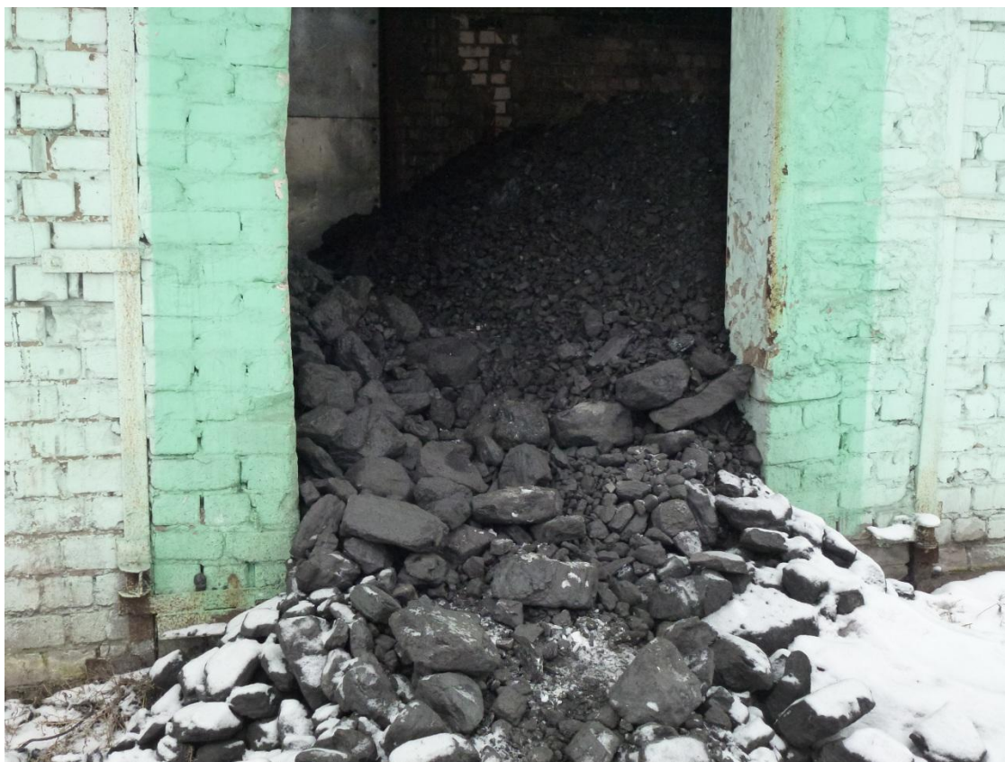
Рис.6. Фотография склада каменного угля.
