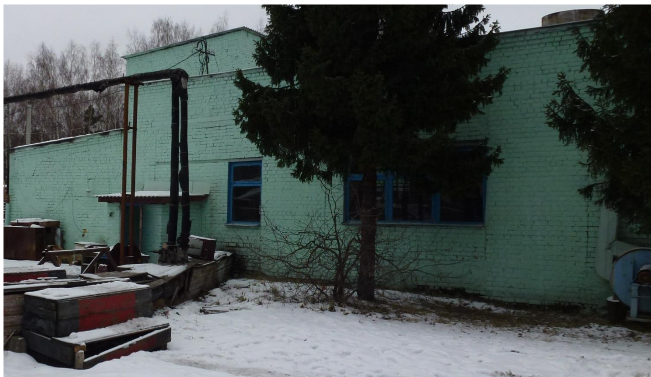
Рис.1. Фотография объекта (котельной), на которой проводились испытания.
