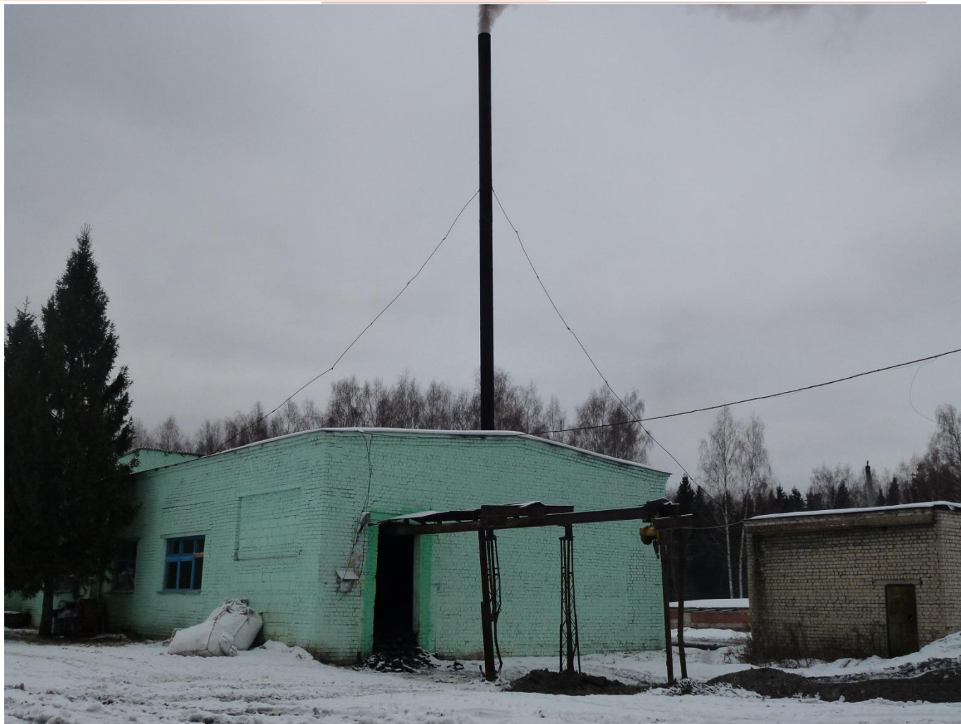
Рис.2. Фотография объекта (котельной), на которой проводились испытания.
