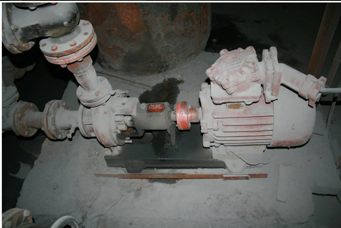
Рис.2. Фотография сетевого насоса К 45-30
