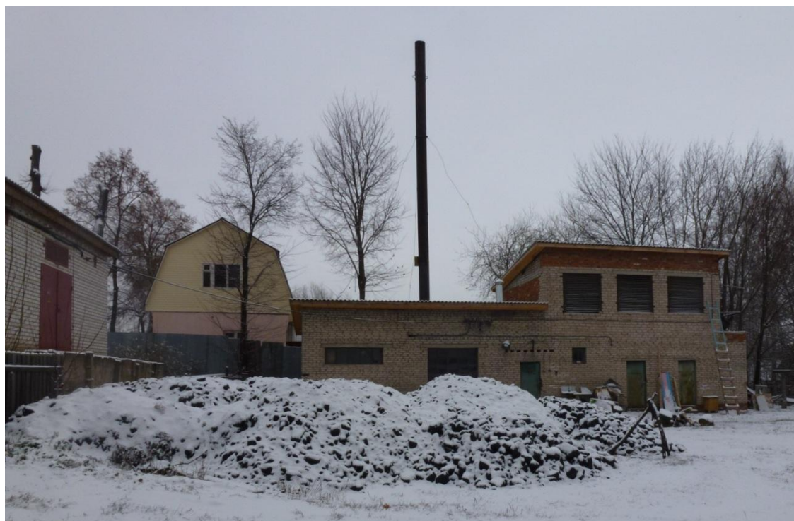
Рис.1. Фотография объекта (котельной), на которой проводились испытания.
