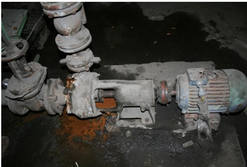
Рис.№3. Фотография сетевого насоса К 20-30
