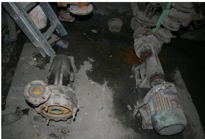
Рис.№3. Фотография сетевого насоса К 20-30
